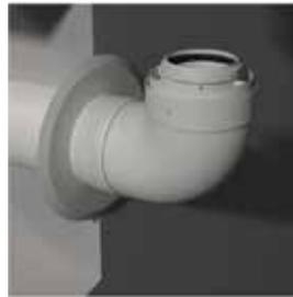
Bogen 87° an die waagrechte Verbindungsleitung anschließen. Nach dem Bogen werden die Funktionsformteile (Putztüranschluss, Luftansaugstück) positioniert. Die Reihenfolge ist flexibel. Der Putztüranschluss ist in Abstimmung mit dem bevollmächtigten Rauchfangkehrermeister zu setzen.
