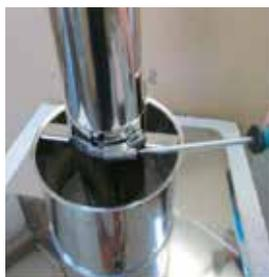
Metallisches Endrohr mit der Schelle verbinden
