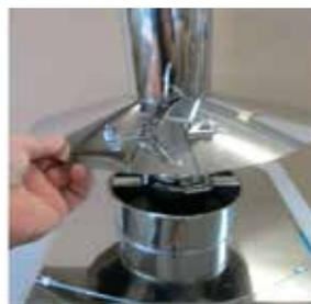
Wetterhaube über Mündungsrohr und über die beiden Haken schieben und befestigen.
