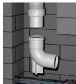
Gegenüber der Anschlussöffnung Bohrung anbringen (d=10-12mm).
